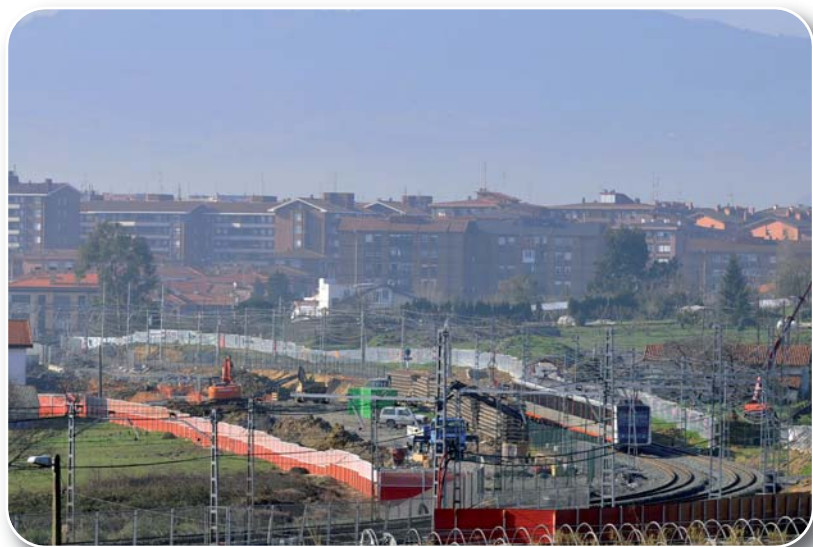
Zona de Andra Mari en donde se construye la nueva estación del metro.
